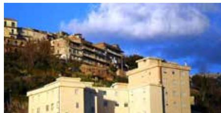
fatto è emerso che il fabbricato risulta caratterizzato da una vulnerabilità sismica estremamente elevata. Pertanto, gli interventi previsti interesseranno in maniera diffusa sia i maschi murari che le strutture voltate, eseguiti mediante rinforzi con fasciature con fibre di carbonio, iniezioni di miscele
